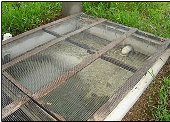
Figura 5. Salida del separador de sólido en la finca de Rubén Serracín, ubicada en Santa Marta.
