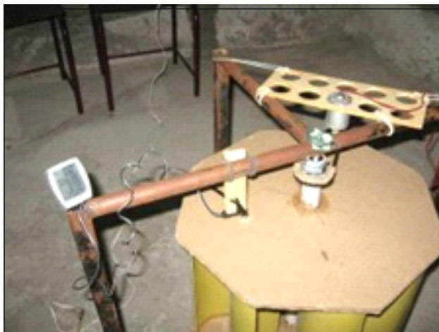
Fotografía 8. Aerogenerador con producción de energía.
