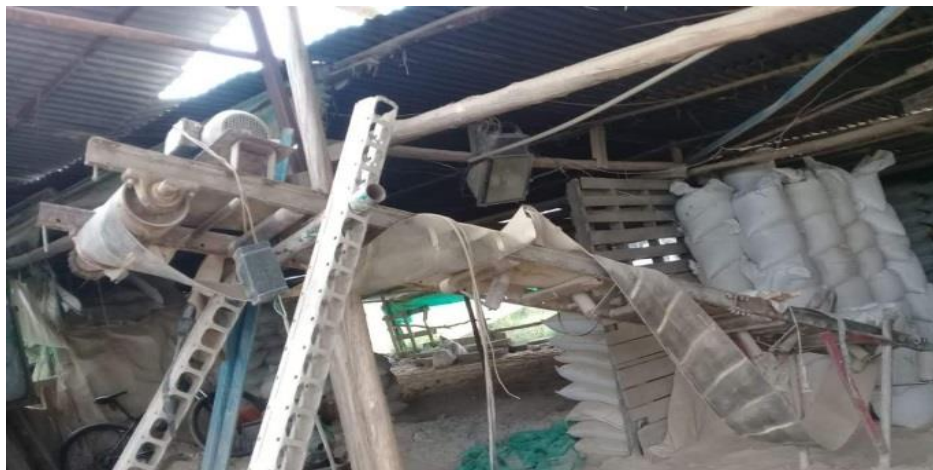
Figura 5. Ubicación de maquinaria
