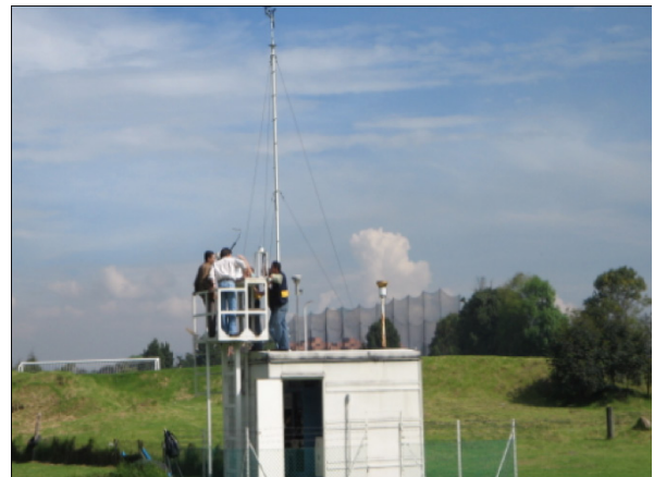
Figura 5. Estación Centro de Alto Rendimiento
