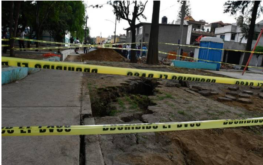
Figure 5. Geological fault Quinta Cerrada avenida 503, Colonia San Juan de Aragón 1ra Sección. Source: Mendoza, 2021
