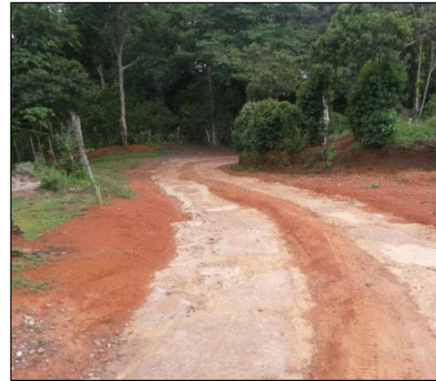
Figura 14. Huellas en concreto reciclado
