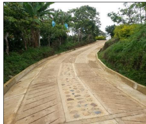
Figura 15. Placa huellas en concreto con cuneta
