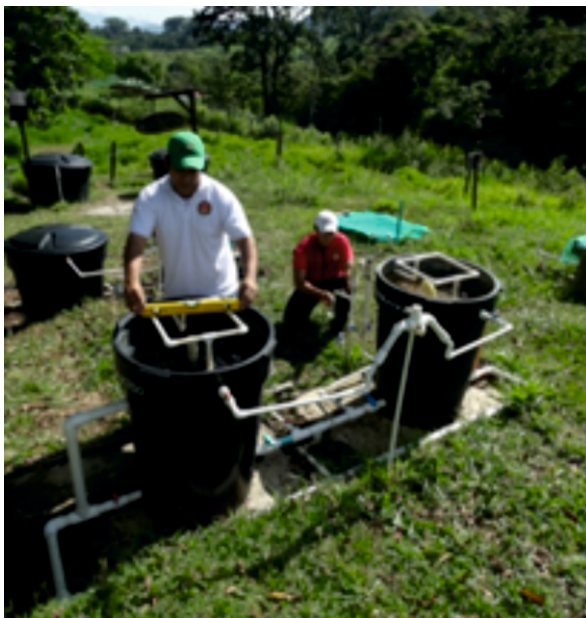
Figura 1. Filtros Gruesos Descendentes FiME adaptado
