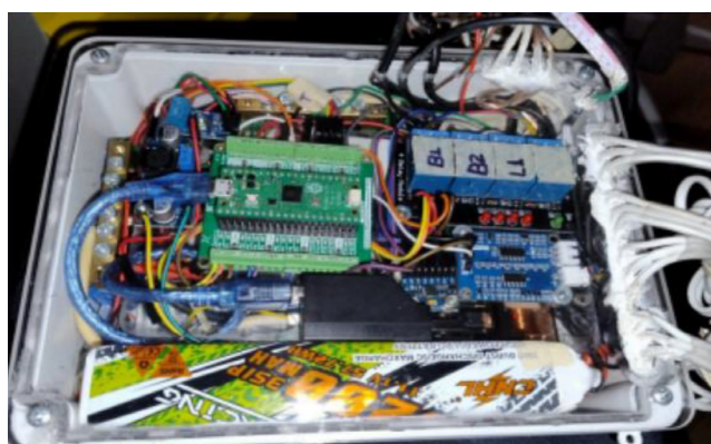
Figura 10. Conexión del circuito y sellado en el casco interno.
