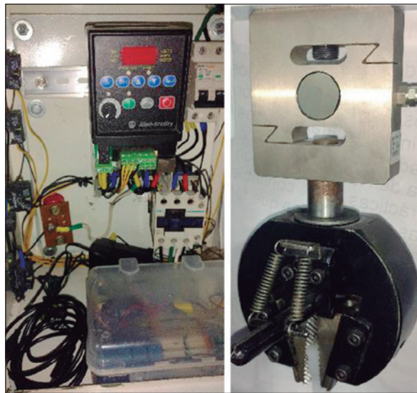
Figura 9. Elementos de mando, control y registro electrónico de carga
